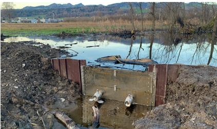
Durch dieses Wehr kann das Wasser im Riet für die Streumahd abgesenkt werden. (Foto: Pro Natura SGA)
