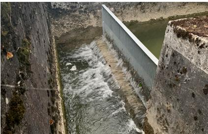
Zum Schutz der Fische wurde im Einlaufbecken ein vertikaler Fischrechen mit Stangenabstand von 12 mm eingebaut. (Foto: Pro Natura SGA)
