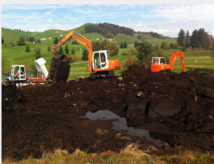
Rodung standortfremder Gehölze als Vorbereitung für die Erdverschiebungen. (Fotos: Pro Natura St.Gallen-Appenzell)
