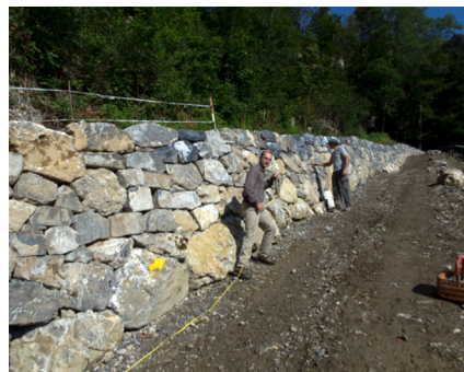
Der Projektleiter Peter Weidmann beim Vermessen der neuen Trockenmauer. (Foto: Altragene)
