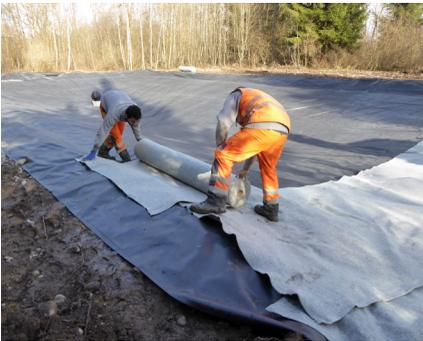
Abb. 7: Zur Abdichtung des Weihers Rifenu wurde eine Folie verwendet, die mit einem Vlies geschützt wird. (Foto: J. Barandun)
