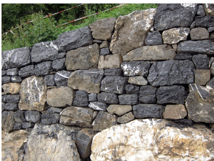
Stabile Trockenmauer in der Porta Romana, Pfäfers. (Foto: P. Weidmann)
