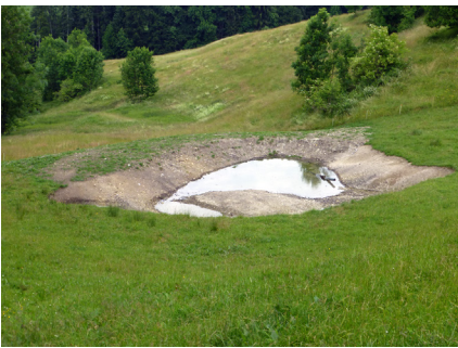
Dieser Weiher wurde im Rahmen des Amphibienförderprojekts Thur-Glatt in Tamoos neu angelegt. (Foto: J. Barandun)
