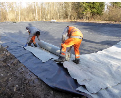
Weiher Rifenu: Verlegung der Folie. (Foto: Jonas Barandun)
