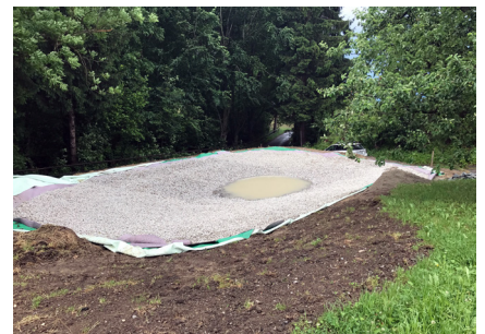
Bauphase: Die mit einem Vlies geschützte Kunststoffolie wurde mit Geröll überschüttet. (Foto: Pro Natura St. Gallen-Appenzell)
