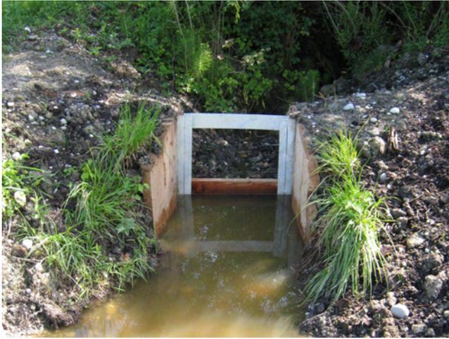
Foto 1: Beim Ausfluss wurde ein Damm mit einer Holzsperrre errichtet. Durch das Einsetzen oder Entfernen von Holzbrettern kann nun die Wasserhöhe im Moor geregelt und optimiert werden. (Foto Pro Natura SGA).
