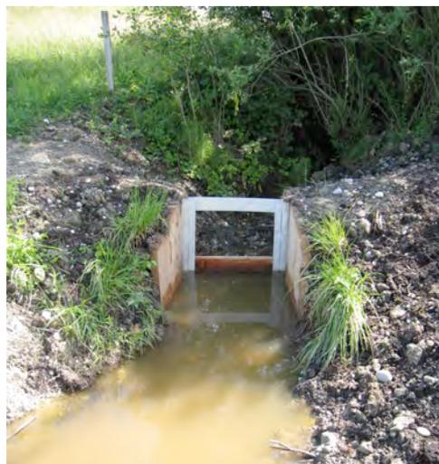
Abb. 1: Sperre zur Regulierung des Wasserspiegels.
