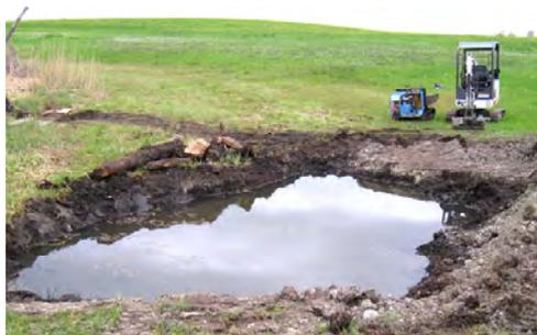
Abb. 2: Der Aushub des neuen Weihers erfolgte mit einem Kleinbagger.
