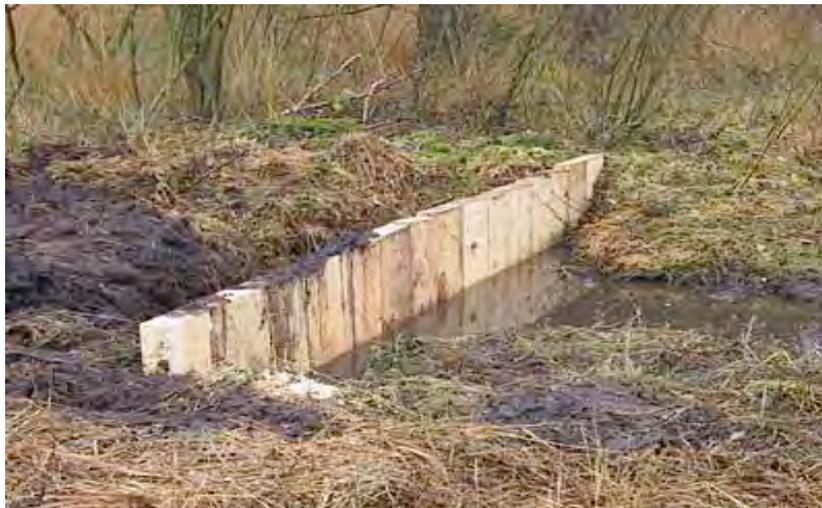
*Eine noch nicht überdeckte Spundwand zur Stauung eines Entwässerungsgrabens.*
