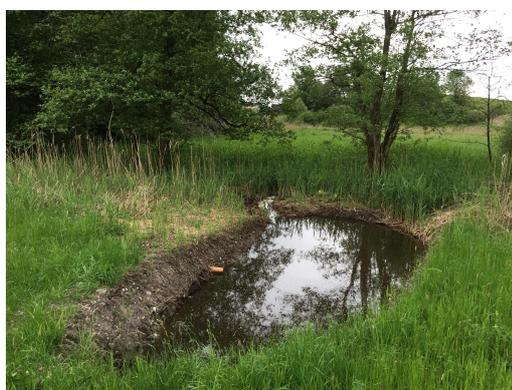
Neu eingebaute Sperre mit höher gestautem Wasserspiegel.
