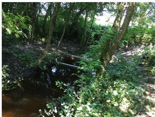
Fertig eingebaute Sperre und Rechen. Die Sperre ist mit einer Kette und Vorlegeschloss gegen unbefugtes Öffnen oder Schliessen des Schiebers gesichert.
