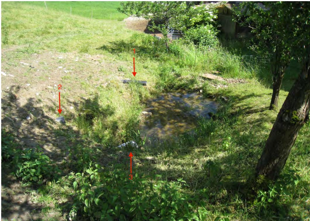
Abbildung 6: Mündung von drei Rohren in ein kleines Gewässer am Dammfuss: 1 Drainage, 2 Ablassrohr und 3 Überlaufröhre (Foto: Pro Natura St.Gallen-Appenzell)
