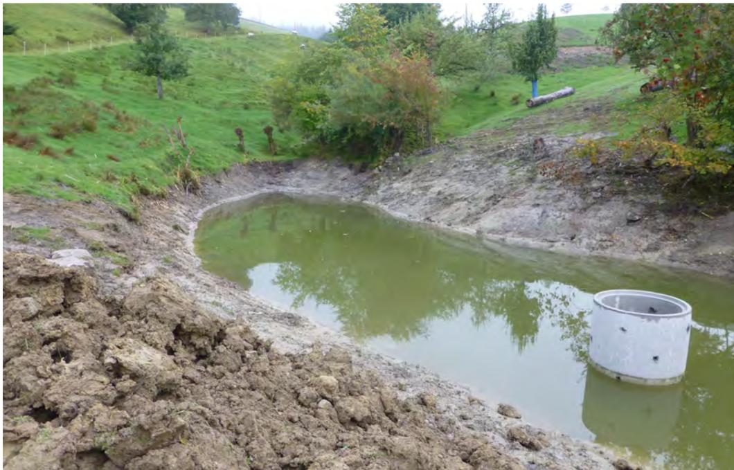
Abbildung 2: Die Ufer des Weihers wurden möglichst flach ausgebildet. Rechts sieht man den Betonschacht des Regulierwerks (Foto: Jonas Barandun).
