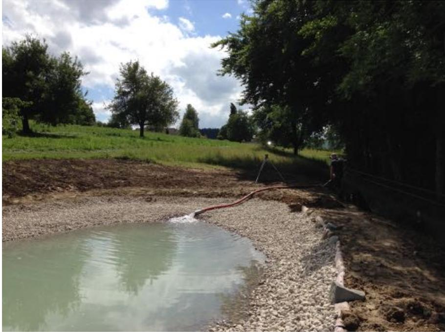
Abb. 6: Füllung des Weihers mit Hydrantenwasser um allfällige Schäden während der erwarteten Regenperiode zu vermeiden (Foto: Ueli Rohner, Schnittstell).
