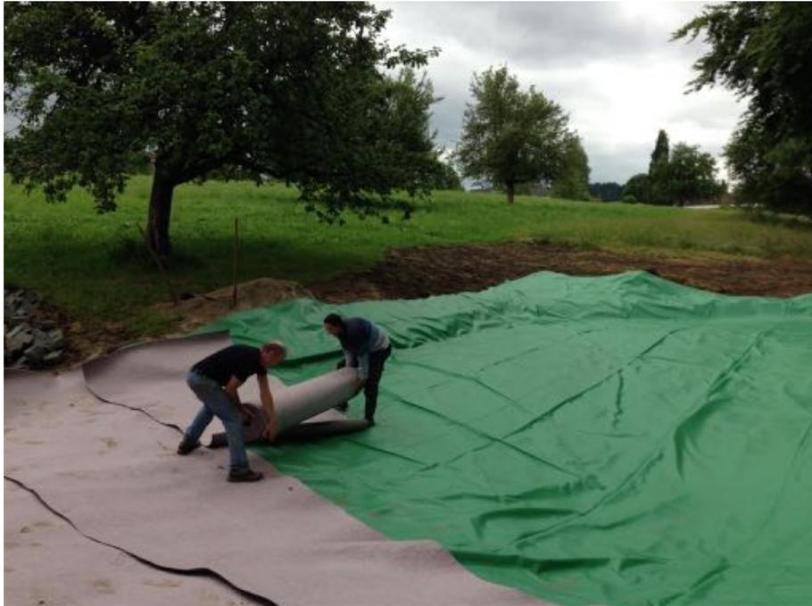
Abb. 4: Verlegung des Kunstfaserfilzes zum Schutz der Sika Folie (Foto: Ueli Rohner, Schnittstell).
