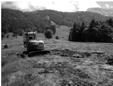
Bagger beim Terrainausgleich des mit Gräben zerschnittenen und noch ausgetrockneten Moores. (Foto: Pro Natura St. Gallen-Appenzell)
