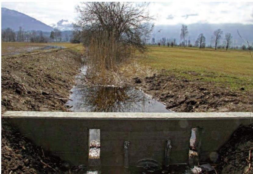
Das Stauwehr beim Hüttengraben ist fertig gestellt und bereits bis zu den Überläufen aufgestaut. Über einen abschliessbaren Schieber kann der Graben vollständig entleert werden.
