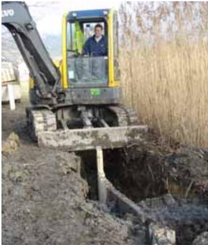
Baggerführer beim Einrammen einer Spundwand zur Sanierung des lecken Dammes
