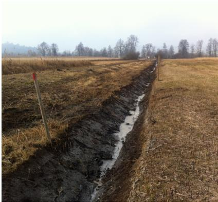
Der Gastergraben wurde frisch ausgebaggert, um eine gute Be- und Entwässerung zu garantieren (Foto: Pro Natura).
