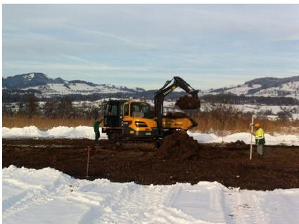
Der Oberboden mit Goldruten wurde 10-20cm tief abgetragen und der Aushub mit Raupendumpfern aus dem Schutzgebiet transportiert (Foto: Pro Natura).
