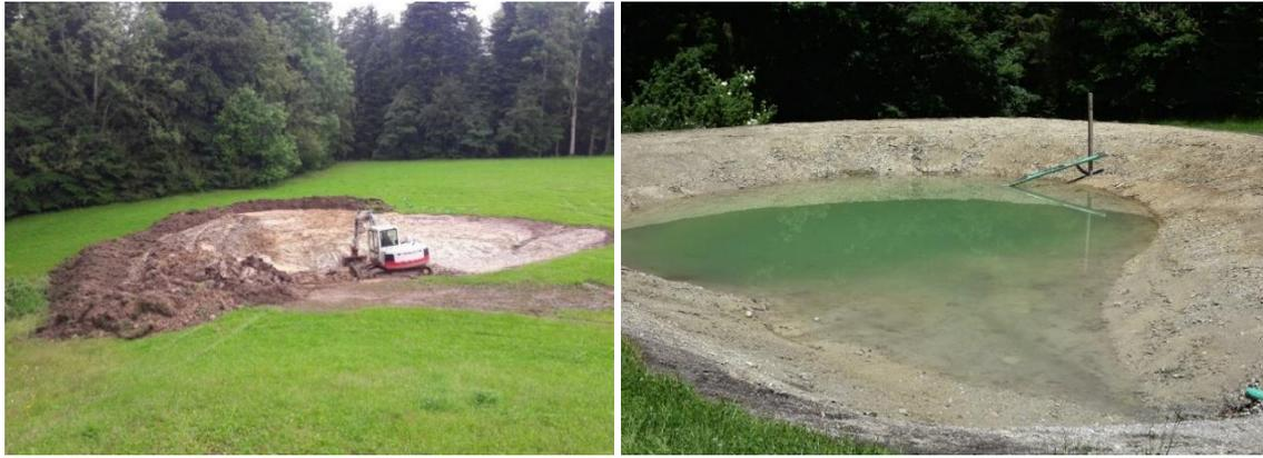
*Der Aushub des lehmigen Bodens mittels Baggereinsatz. Dank dem Zufluss aus einer Hangquelle füllte sich der Weiher in kurzer Zeit mit Wasser.*
