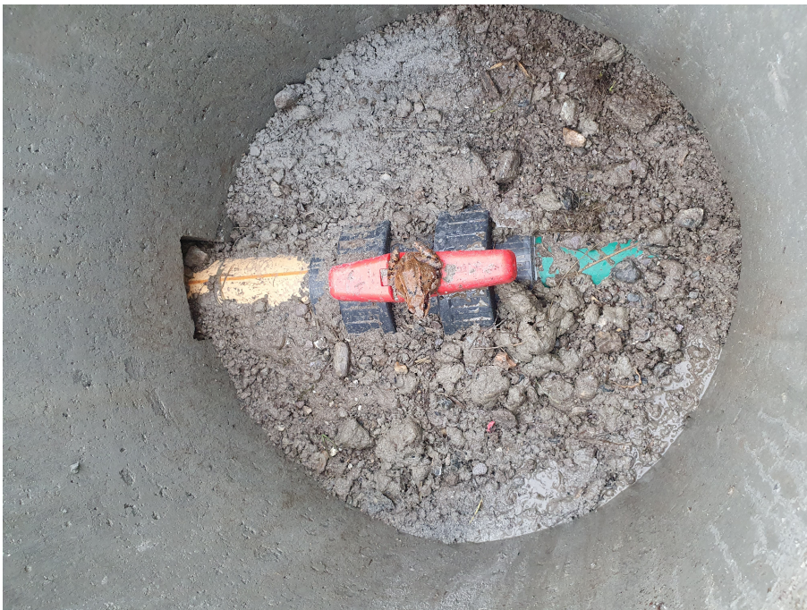
Abb. 7: Der Kugelhahn ist durch einen ausserhalb des Weihers liegenden Schacht geschützt, der abgeschlossen werden kann (Foto: Pro Natura SGA).
