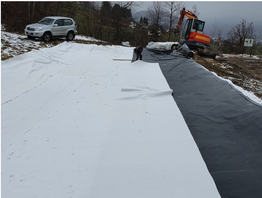
Abb. 5: Die verlegte Folie ist von unten und oben durch ein Vlies geschützt. (Foto: Pro Natura SGA)
