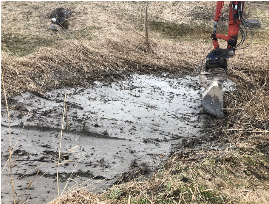
Abb. 2: Mit dem Bagger wird die Vegetationsschicht sorgfältig abgezogen (Foto: Pro Natura SGA)
