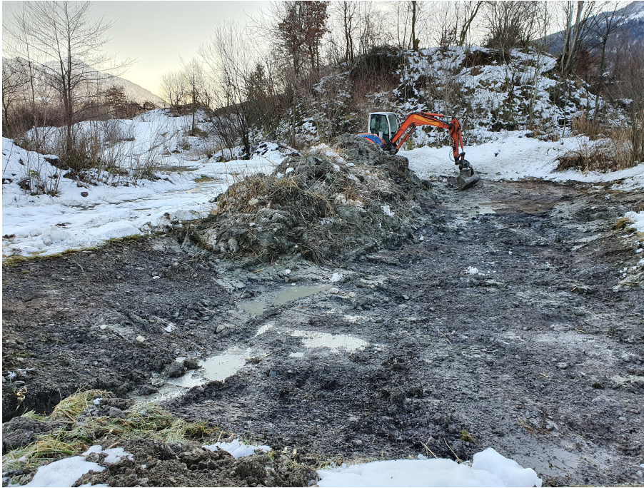
Abb. 4: Beim Weiher Nr. 6 zieht der Bagger die Vegetationsschicht ab (Foto: Pro Natura SGA).
