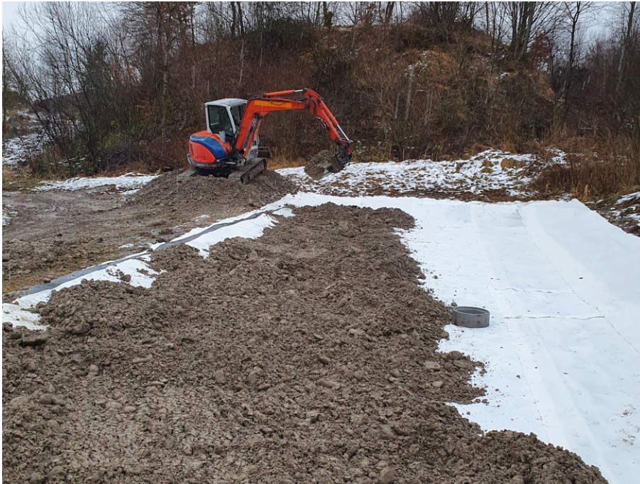
Abb. 6: Die mit Vlies geschützte Folie wird sorgfältig überschüttet. In der Mitte ist noch der Schacht des Ablaufrohrs sichtbar (Foto: Pro Natura SGA).
