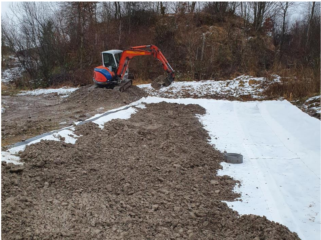
Abb. 5: Die mit Vlies geschützte Folie wird sorgfältig überschüttet. In der Mitte ist der Grundablass mit gelochtem Schacht sichtbar (Sanierung Weiher Nr. 6, erste Etappe 20/21).
