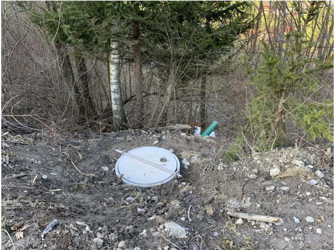
Abb. 6: Der ausserhalb des Weihers liegende Kugelhahn wird durch einen abschliessbaren Schacht geschützt (Sanierung Weiher Nr. 4, erste Etappe 20/21).
