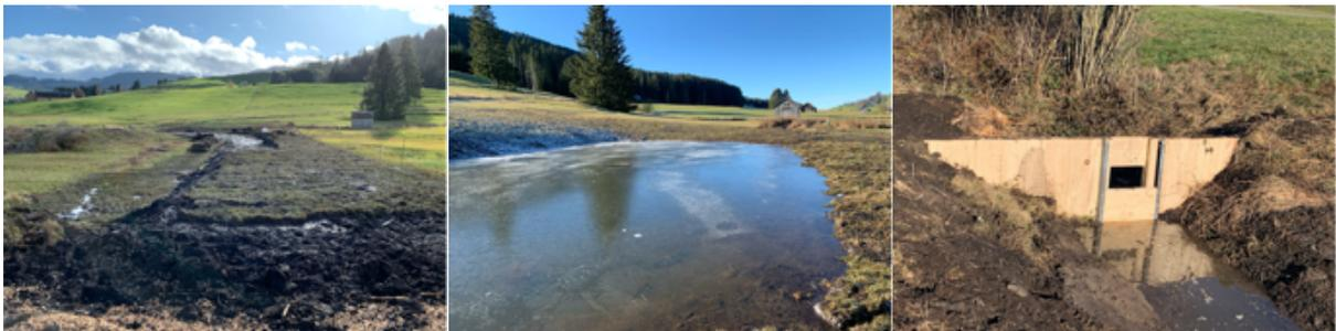
Fotos: Angehobenes Terrain mit wiedereingebauten Vegetationsziegel (links), ausgebaggelter und mit einer Flachwasserzone neu gestalteter Weiher (Mitte), regulierbares Wehr zum Aufstau des Wassers und zur temporären Absenkung für die Streuemahd (rechts).
