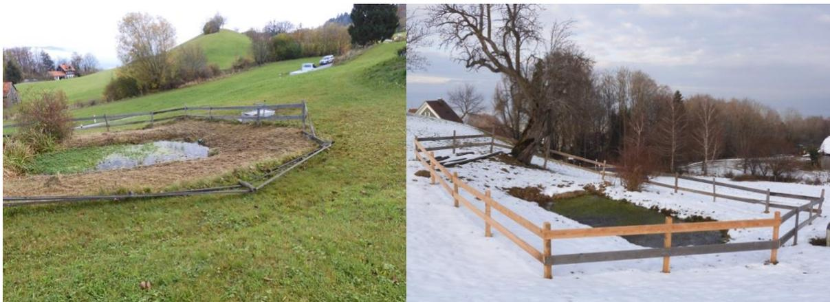
Fotos: Der während eines Herbststurmes 2021 beschädigte Zaun in der Hub wurde mit lokalem Lärchenholz repariert.
