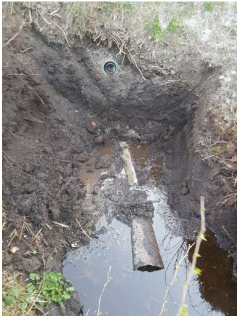
Abb. 2.: Freigelegtes altes Durchlassrohr, welches offensichtlich das Wasser kaum mehr ableiten kann. Oberhalb das neue kleinere Durchlassrohr, welches durch den Strassenkörper gestossen wurde, für die Ableitung des Wasser aus dem noch zu bauenden Schacht (Foto: Forrerbau AG). Abb. 3: Neuer Schacht und freigelegter gewachsener Boden vor Einbau des Lehmriegels (Foto: Forrerbau AG).
