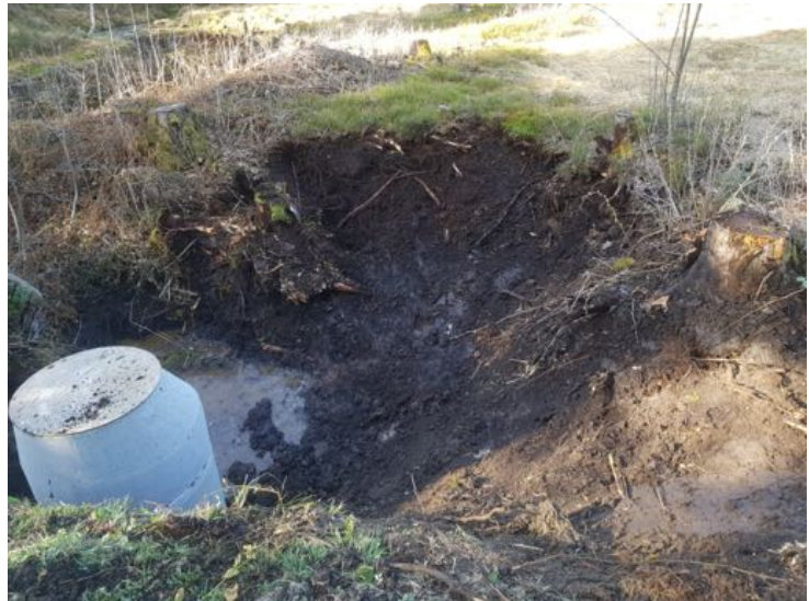
Abb. 2.: Freigelegtes altes Durchlassrohr, welches offensichtlich das Wasser kaum mehr ableiten kann. Oberhalb das neue kleinere Durchlassrohr, welches durch den Strassenkörper gestossen wurde, für die Ableitung des Wasser aus dem noch zu bauenden Schacht (Foto: Forrerbau AG). Abb. 3: Neuer Schacht und freigelegter gewachsener Boden vor Einbau des Lehmriegels (Foto: Forrerbau AG).
