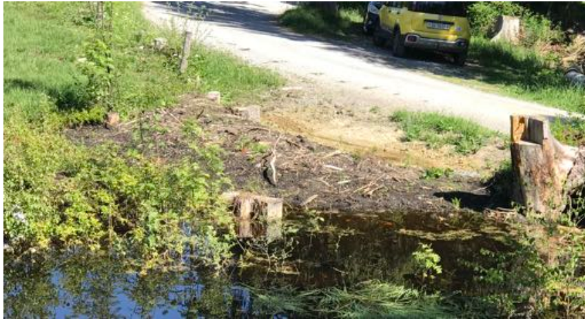
Abb. 6: Fertig erstellter mit Humus überschütteter Damm nach dem ersten Regenfall. Der Wasserstand im Staubereich konnte um mehr als 40 cm angehoben werden (Foto: Pro Natura St. Gallen-Appenzell).
