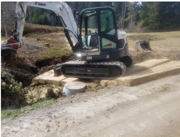
Abb. 4: Einbau des Lehmriegels mit dem Bagger (Foto: Forrerbau AG). Abb. 5: Der Lehm wurde auf einer Breite von über 1 m stark verdichtet (Foto: Forrerbau AG).
