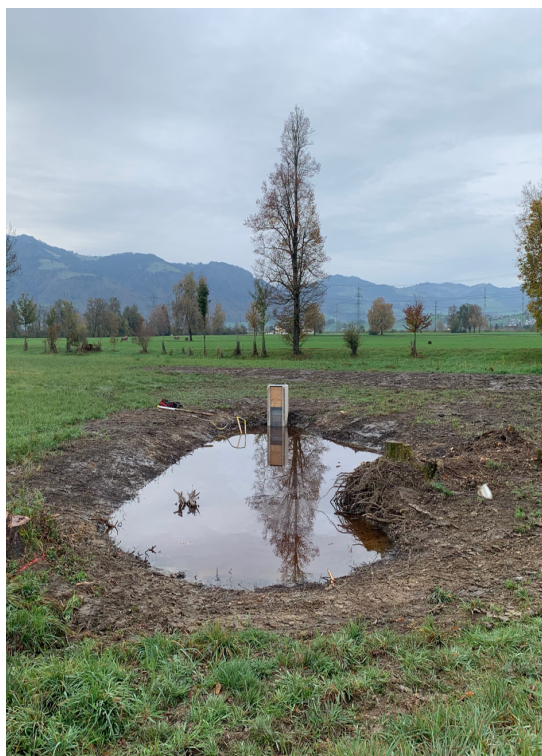
Teichmönch (links) und umgebaute Meliorationsschächte zur Regulierung des Wasserstands im nationalen Flachmoor (rechts).
