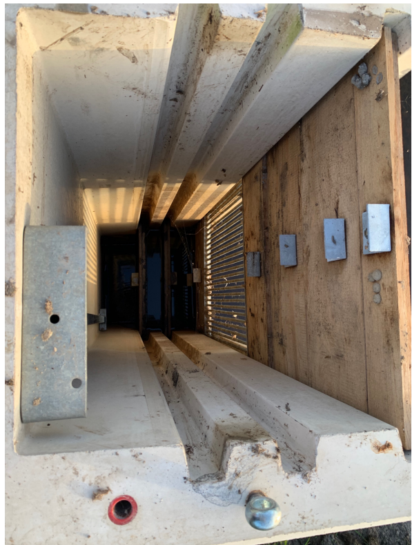
Teichmönch bei der Flutwiese (links). Der Wasserstand wird durch das Einfügen von 16 cm hohen Brettern reguliert (abgelassener Zustand).
