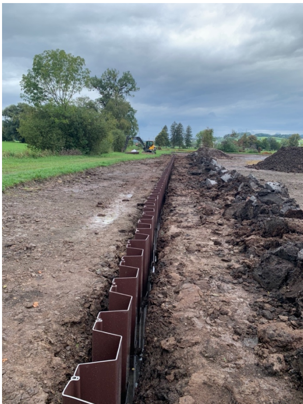
Eingebaute Vinylspundwand (links) und Einbau der Holzspundwand (rechts)
