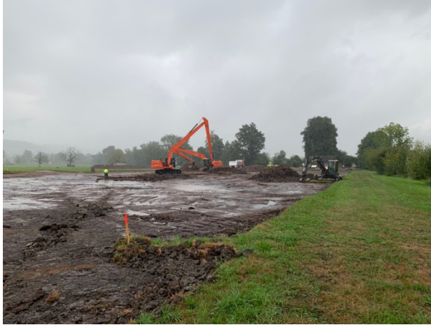
Ausbaggern der Flutmulde und Modellierung der Flutwiese (links), fertig modelliertes Gelände mit eingebautem Teichmönch (rechts).
