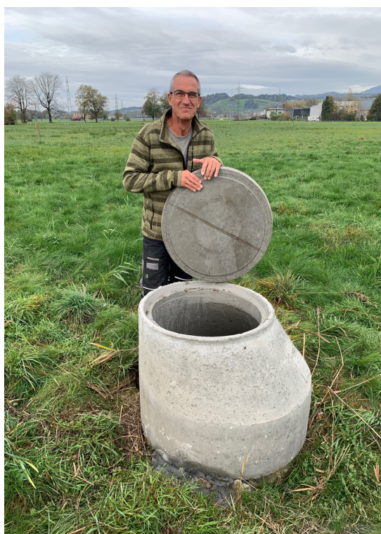
Neuer Schacht im Flachmoor(links) mit eingebauter Einrichtung zur Befestigung eines Steigrohrs (rechts)
