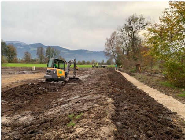
Überschüttung der Spundwände.
