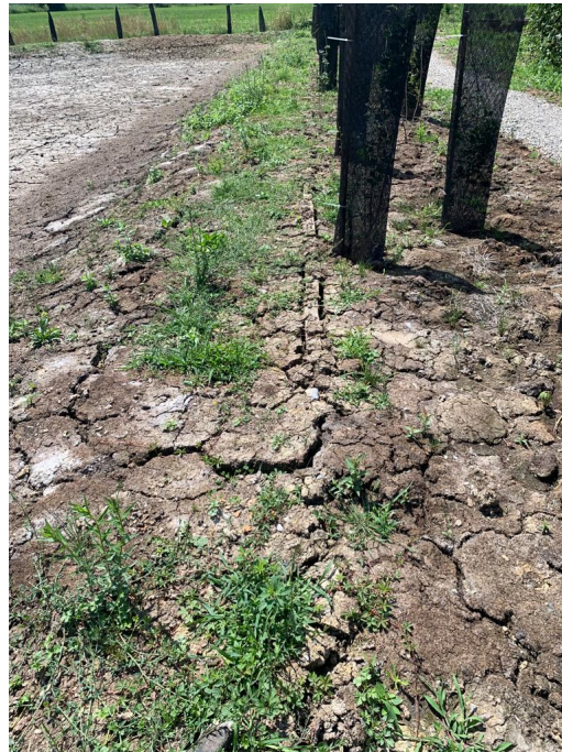
Aufgrund der Trockenheit herausstehende Holzspundwand S4 (oben) und Vinylspundwand S1 (unten).
