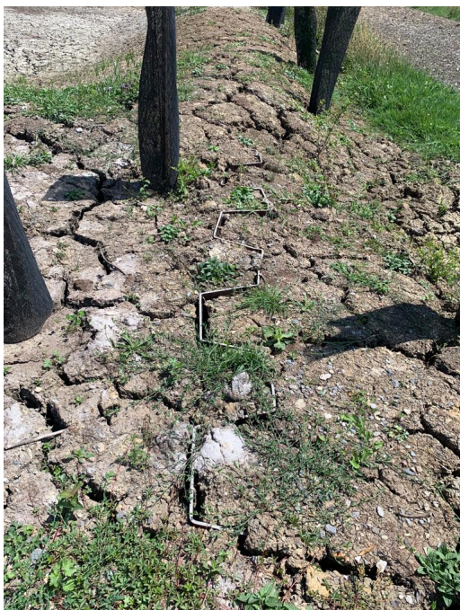
Aufgrund der Trockenheit herausstehende Holzspundwand S4 (oben) und Vinylspundwand S1 (unten).
