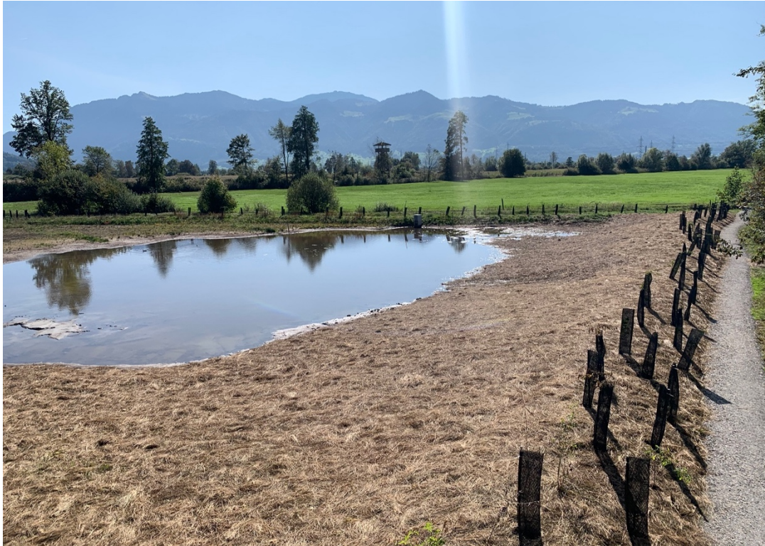
Wieder überschüttete Holzspundwand (rechts im Bild). Das Bodenmaterial für die Neueindeckung wurde von der Flutwiese entnommen. Auf der Fläche wurde zum Schutz vor Austrocknung und zur Direktbegrünung Streue aus den umliegenden Flachmoorflächen ausgebracht.
