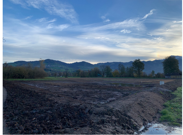
Ausbaggern der Flutmulde und Modellierung der Flutwiese (links), fertig modelliertes Gelände mit eingebautem Teichmönch (rechts).
