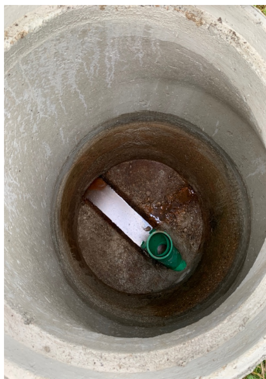
Neuer Schacht im Flachmoor(links) mit eingebauter Einrichtung zur Befestigung eines Steigrohrs (rechts)
