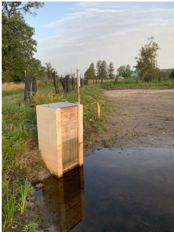
Teichmönch bei der Flutwiese (links). Der Wasserstand wird durch das Einfügen von 16 cm hohen Brettern reguliert (abgelassener Zustand).
