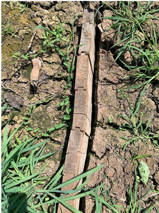
Aufgrund der Trockenheit herausstehende Holzspundwand S4 (oben) und Vinylspundwand S1 (unten).
