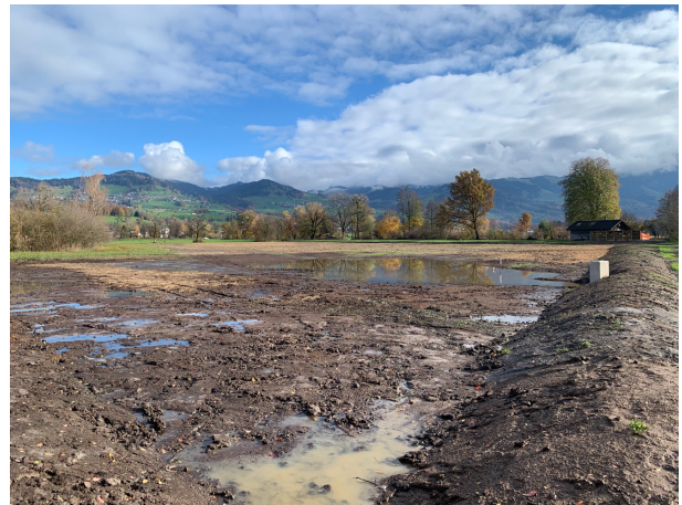
Ausbaggern der Flutmulde und Modellierung der Flutwiese (links), fertig modelliertes Gelände mit eingebautem Teichmönch (rechts).
