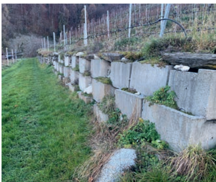
Zu ersetzende, standortfremde Betonelemente im Rebberg Freudenberg, Bad Ragaz. (Bild 10: Pro Natura SGA)
