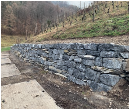
Diese Trockenmauer wurde vollständig ab- und wieder aufgebaut. (Bild 12: Pro Natura SGA)
