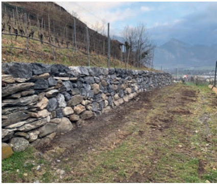
Die Betonelemente (siehe Bild 10) wurden entsorgt und die Mauerpartie fachmännisch neu aufgebaut. (Bild 11: Pro Natura SGA)
