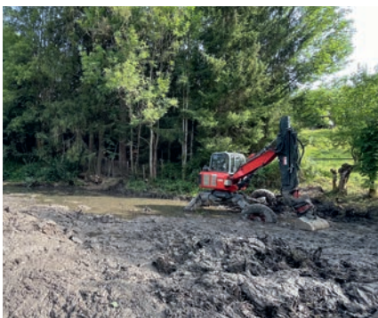
Baggerarbeiten zur Entschlammung des ehemaligen Sägeweiher Bach, Trogen AR. (Bild 9: Pro Natura SGA)
