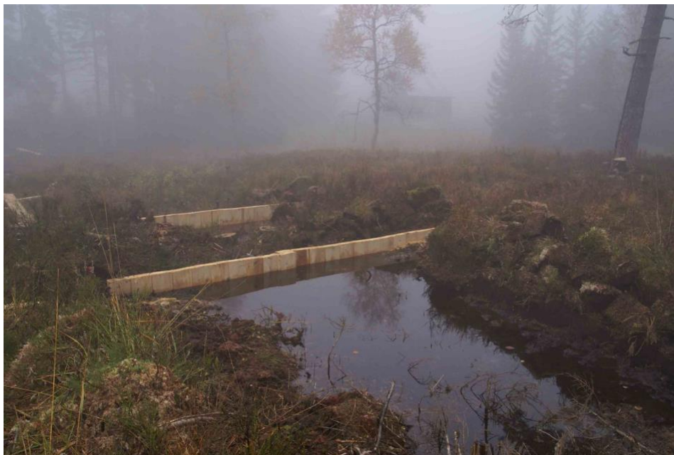
Abb. 7: Beispiel von Holzspundwänden zum Einstau eines Grabens
