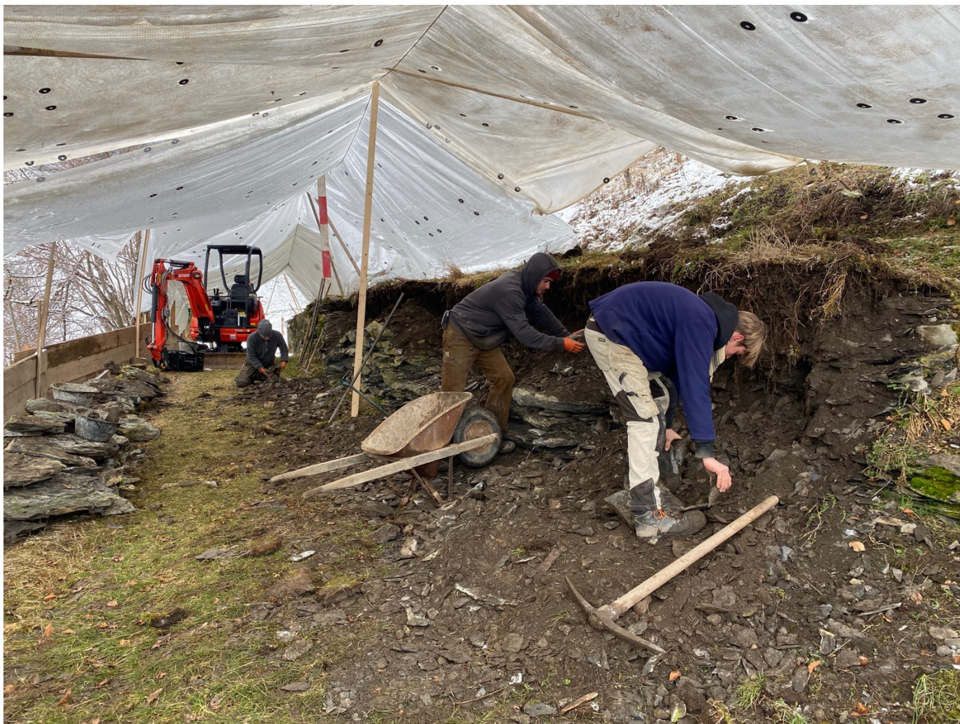
Abbruch eines Mauersegments
