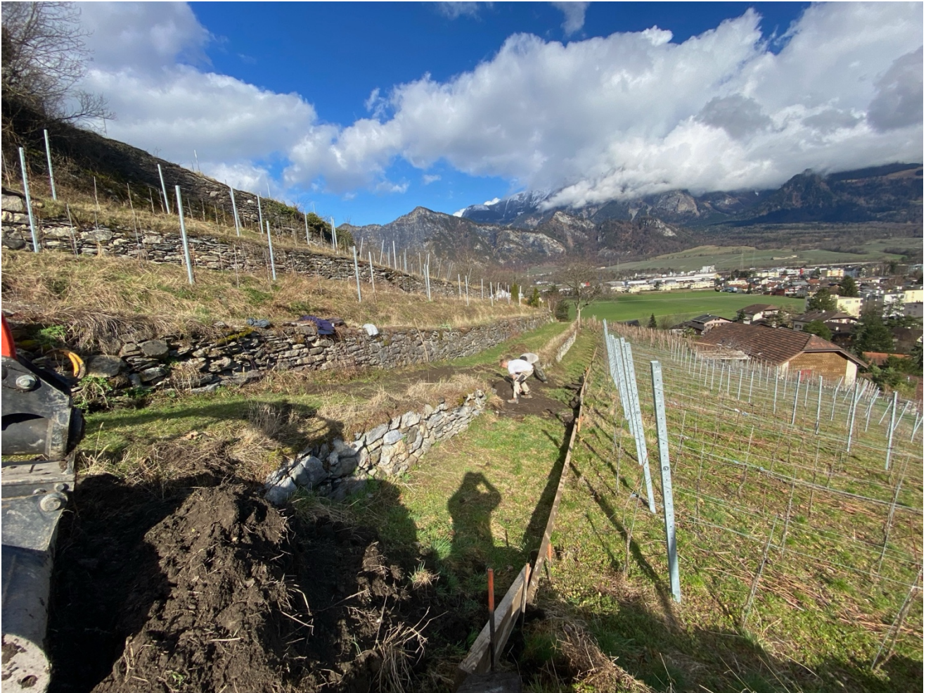
Mauerpartie während der Sanierung; im Vordergrund entsteht der neue Zugang zu den Reben
