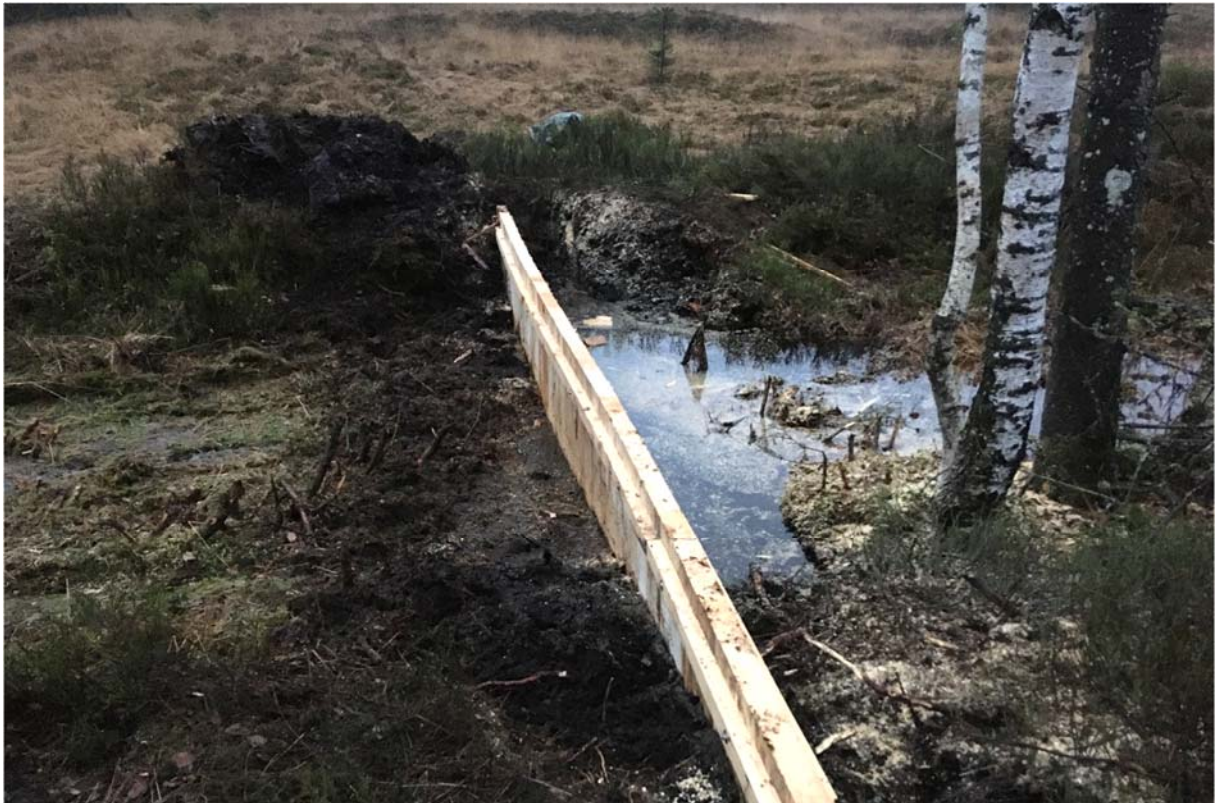
Abbildung 3a: Holzspundwand vor Torfeindeckung (Foto Naturplan AG).
