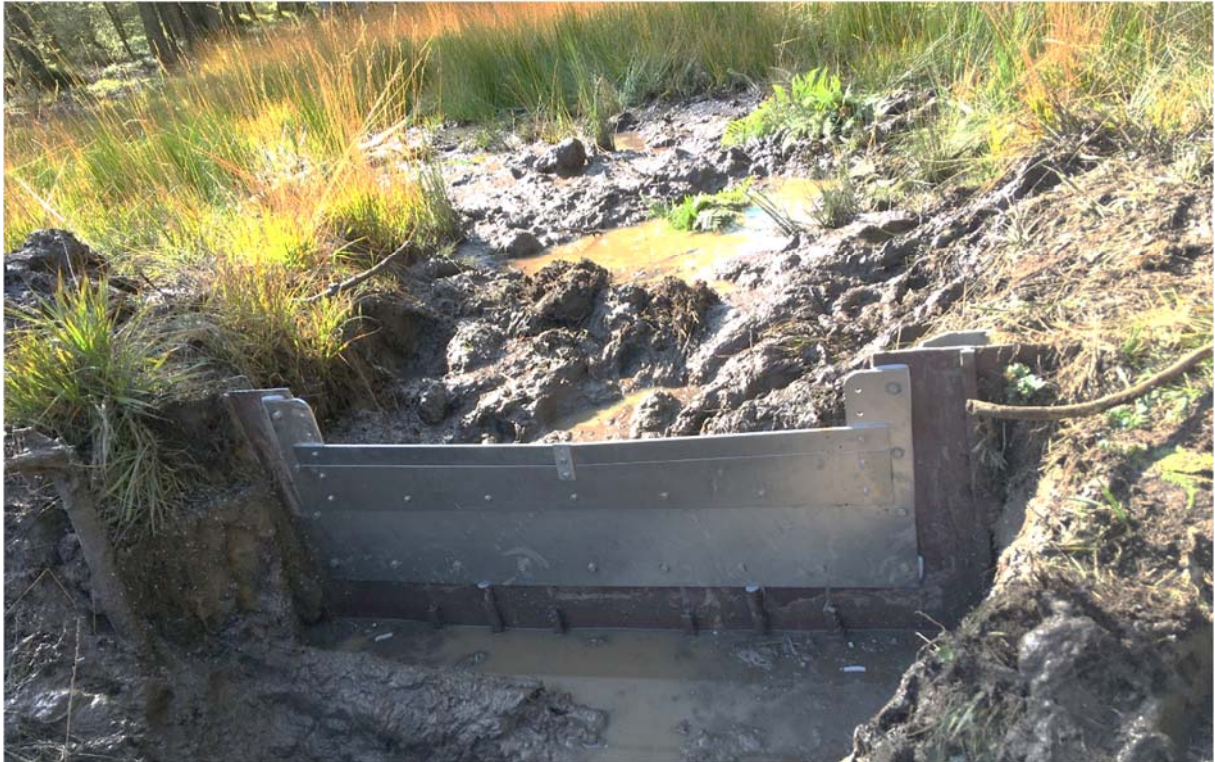
Abbildung 4: Höhenregulierbarer Überlauf (Foto Naturplan AG)
