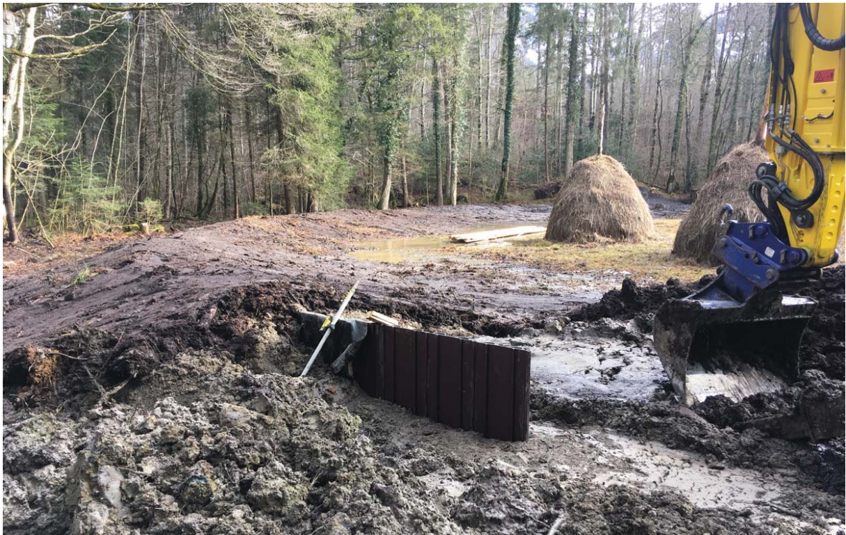
Abbildung 3c: Vinylspundwand mit Lehmkern im Bauzustand. (Foto Naturplan AG)
