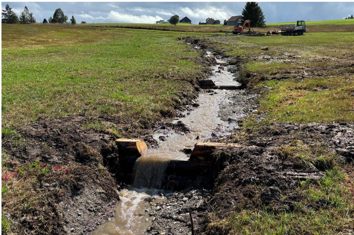
Abbildung 7: Angehobene Grabensohle und Schwellen zur Erosionssicherung (Foto Naturplan AG)
