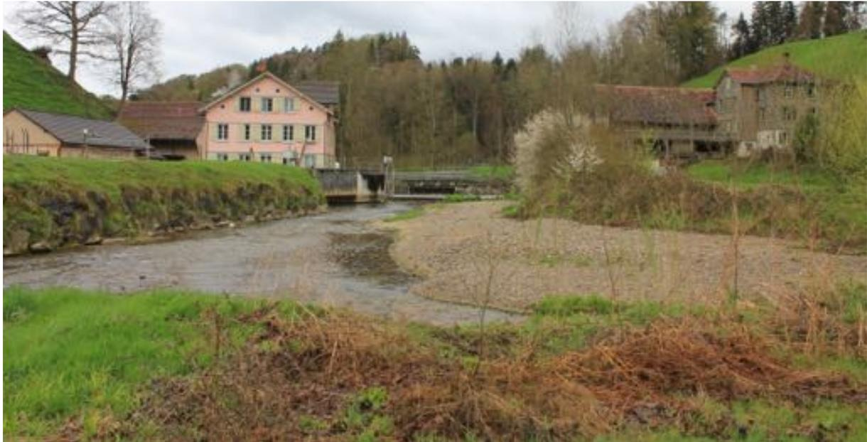
*Abb.2: Mündungsbereich des Gossauer Dorfbaches in die Glatt. Im Hintergrund das Stauwehr der Wasserkraftanlage Isenhammer VI/176. Am linken Flussufer wurden die bestehenden Verbauung belassen, da dort keine Erosionen erwünscht sind.*
