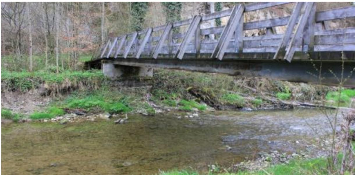
*Abb.8/9: Auswirkungen des fehlenden Geschiebetriebs der Glatt. Abb. 8: Eintiefung der Sohle nördlich der Brücke, erkennbar durch den markanten Absturz und Abb.9: Freilegung des Brückenpfeilers.*
